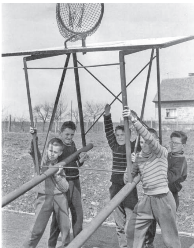
Zdroj: Archiv školy: Stavba hřiště, 1966
