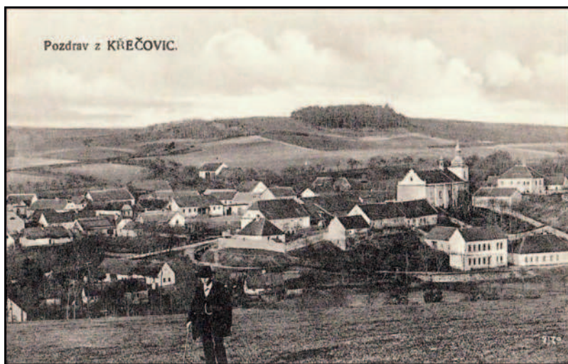
Pohled na Křečovice – dobová pohlednice z roku 1926
